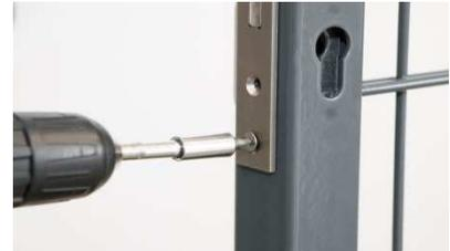
2. Montieren Sie den Profilzylinder.
